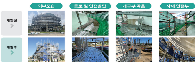
(주)디아엔지니어링의 원형 시스템 비계. 세계 최초로 개발돼 현장에 적용된 볼 탱크(Ball Tank) 전용 시스템 비계이다.
